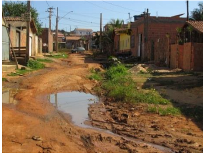
Calles del barrio Bela Vista sin asfalto ni alcantarillado
